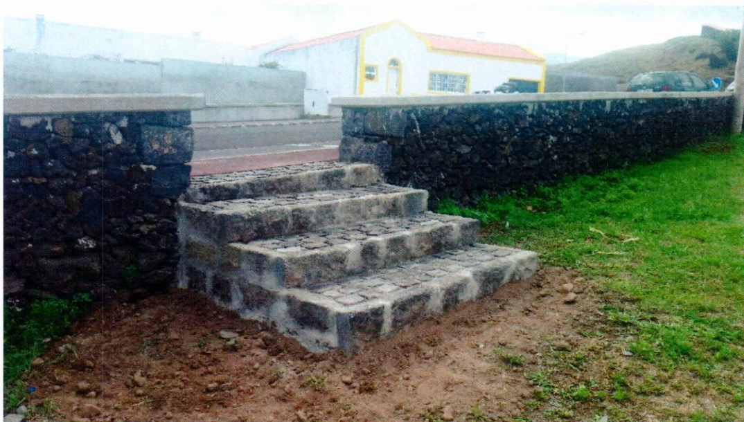
Fotografia 2 – Aspeto final da escada de acesso à Rua José Botelho do Rego Duarte.
