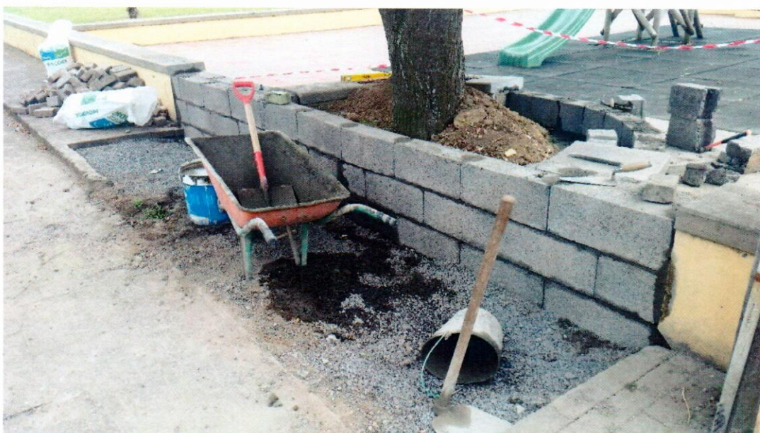
Fotografia 3 – Trabalhos de reparação do espaço envolvente ao parque infantil da Rua do Padre Inácio.
