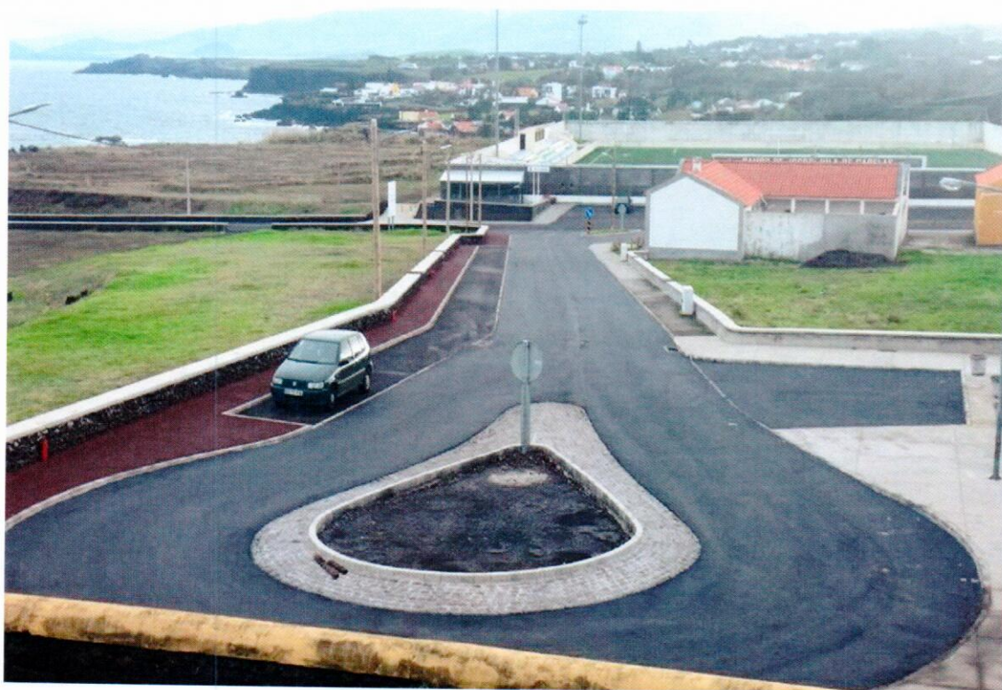
Fotografia 3 – Pavimentação de troço na Rua do Sertão (Pedras Negras).
