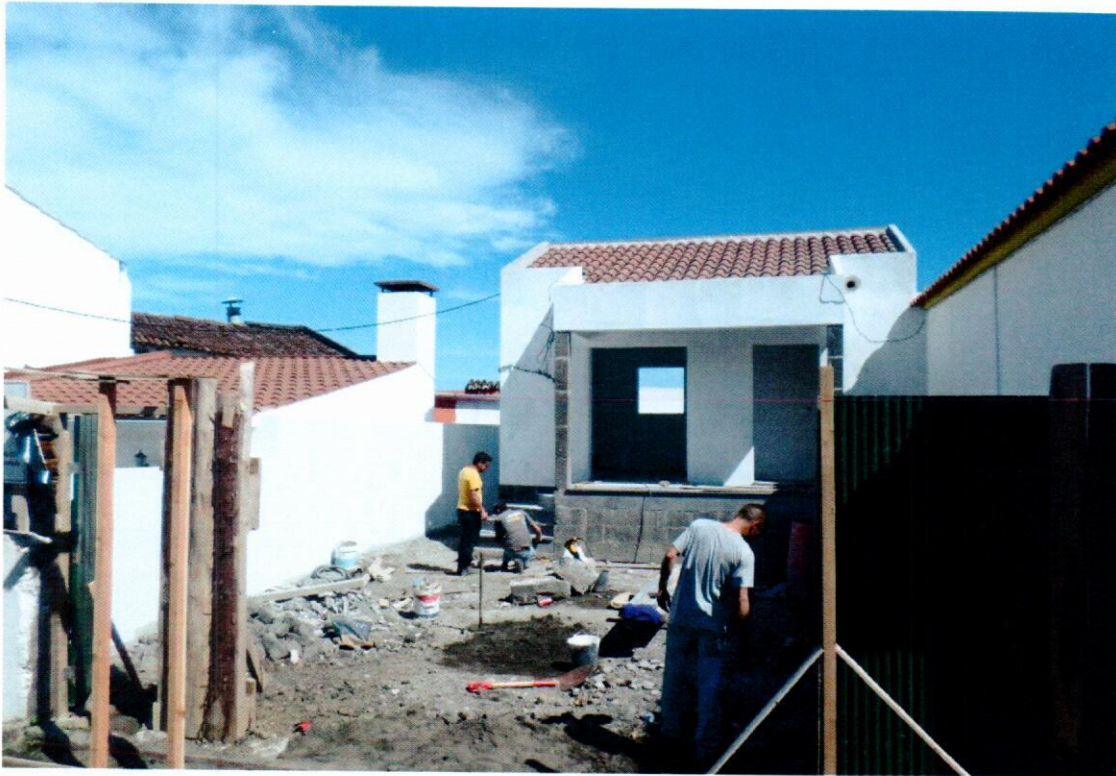
Fotografia 10 – Sede do Clube de Patinagem (Exterior).
