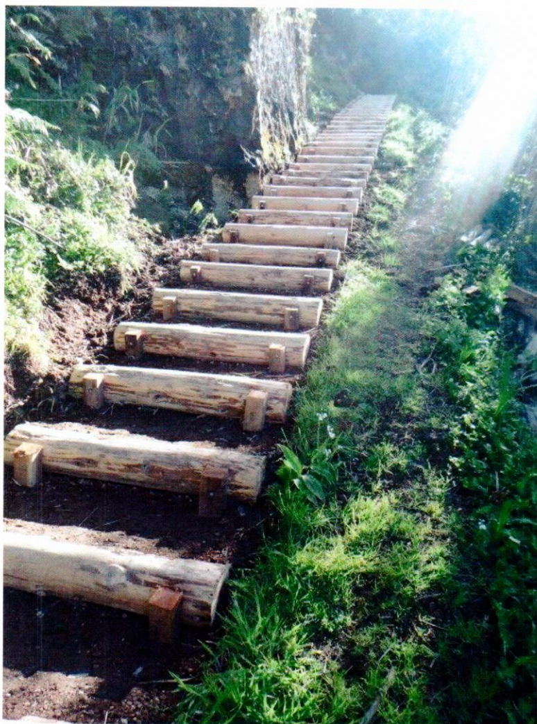
Fotografia 7 – Escadaria construída no trilho pedestre das Pias.
