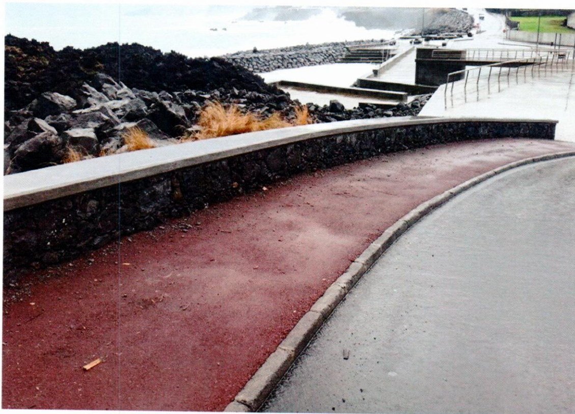
Fotografia 2 – Muro do circuito de manutenção do Sertão reconstruído.
