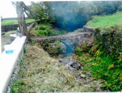
Foto 3 - Rua dos Odres (recuperação de ponte).
