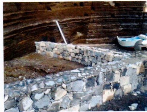
Foto 4 - Porto de Pescas (muro de proteção).
