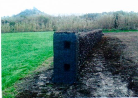
Foto 7 - Caminho das Pias (muro de proteção).
