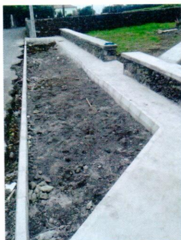
Foto 1 - Rua dos Odres (baía de estacionamento).
