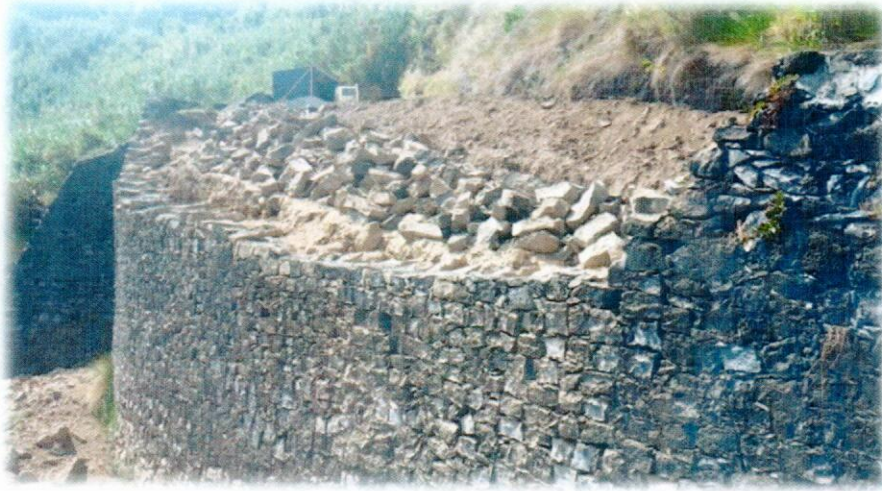
Trabalhos de demolição para correção do paredão das Pias.
